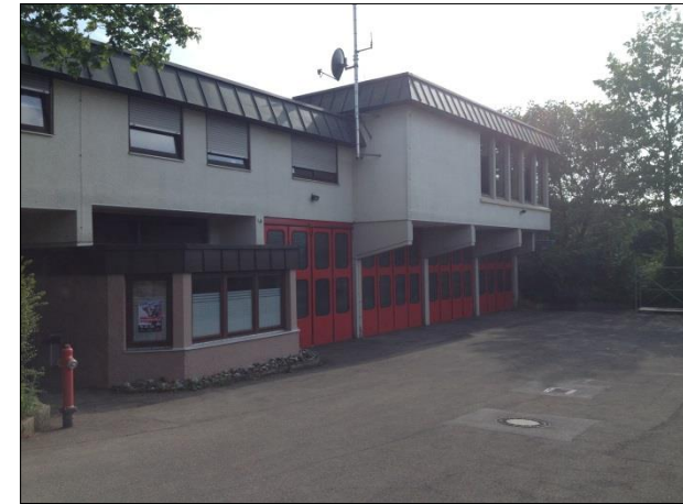
Standort: Rechbergstraße 40, 71336 Waiblingen Quelle Bildmaterial: L&R, Juli 2015
